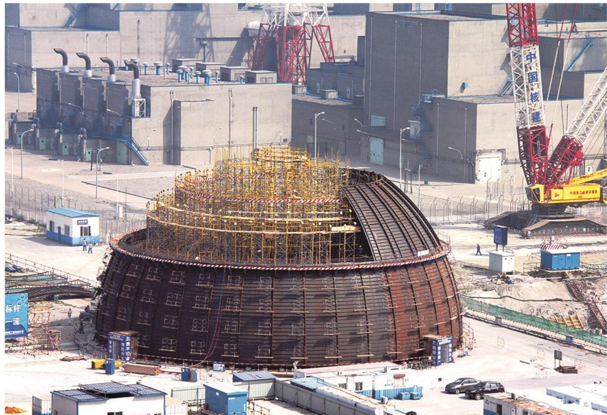
核岛穹顶模块化制作 Modular fabrication of nuclear island dome
