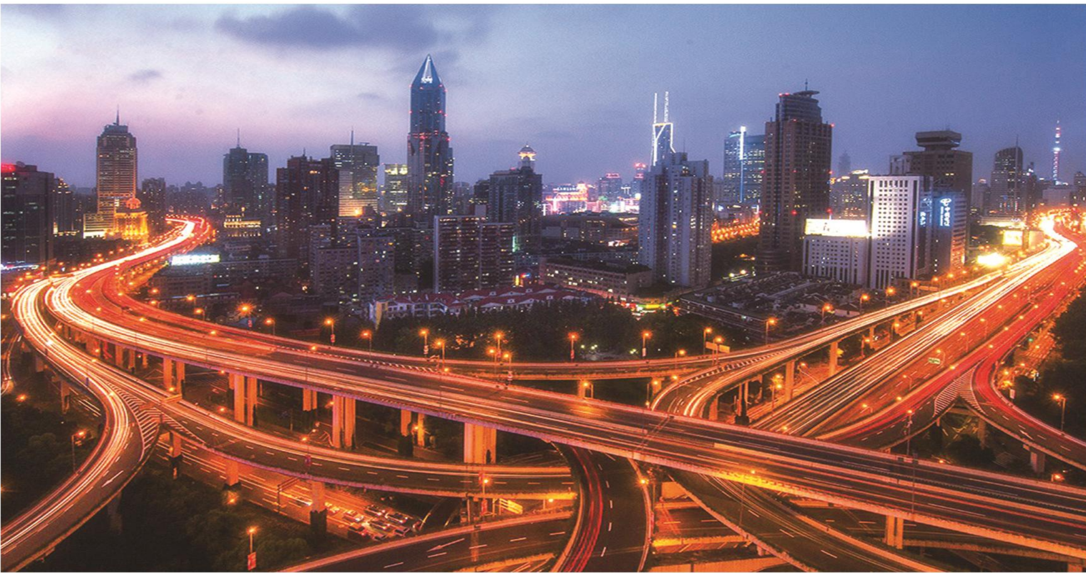
上海嘉闵高架工程 Shanghai Jiamin Elevated Project
