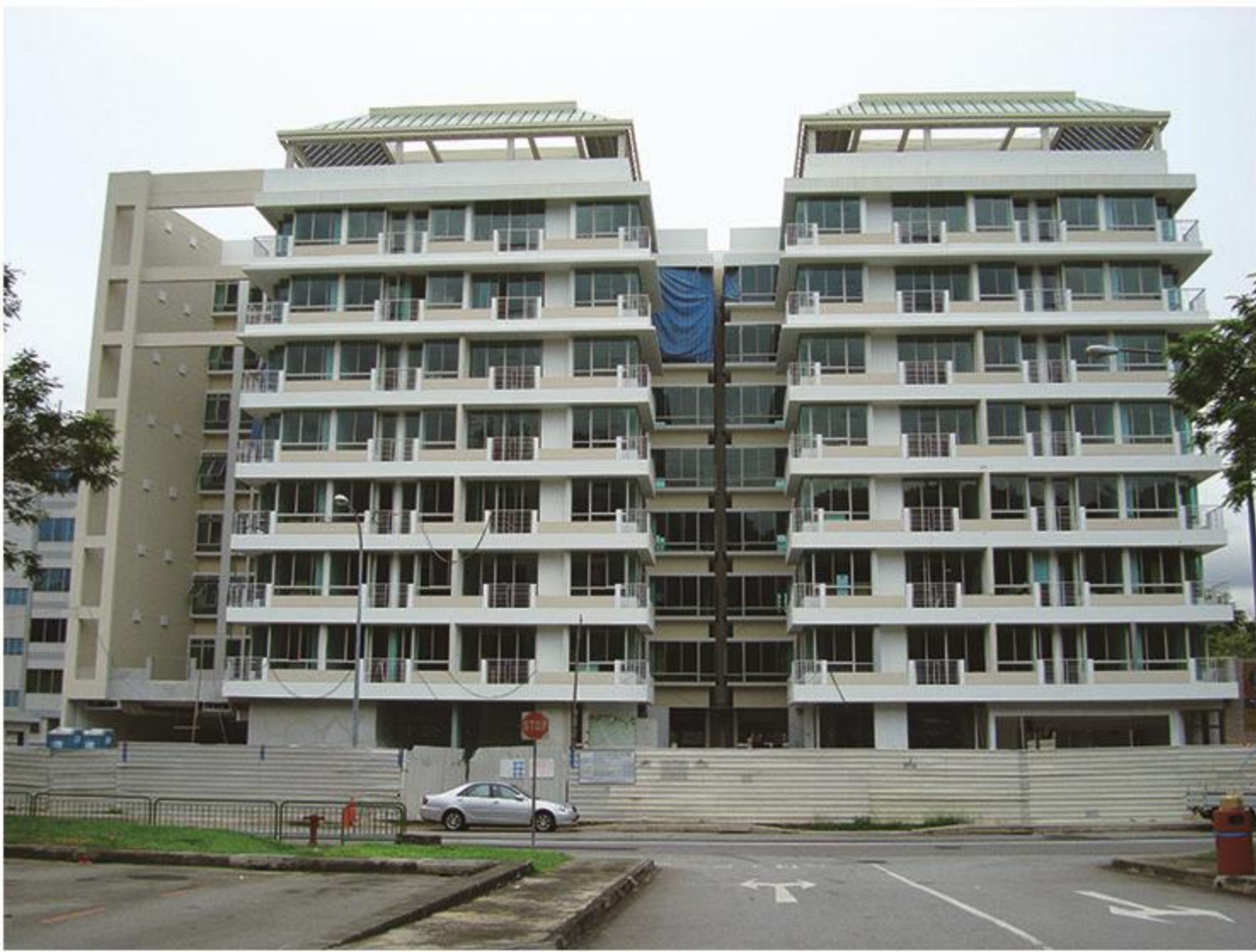
新加坡麦肯锡仁恒公寓项目 Singapore McKinsey Renheng Apartment Project
