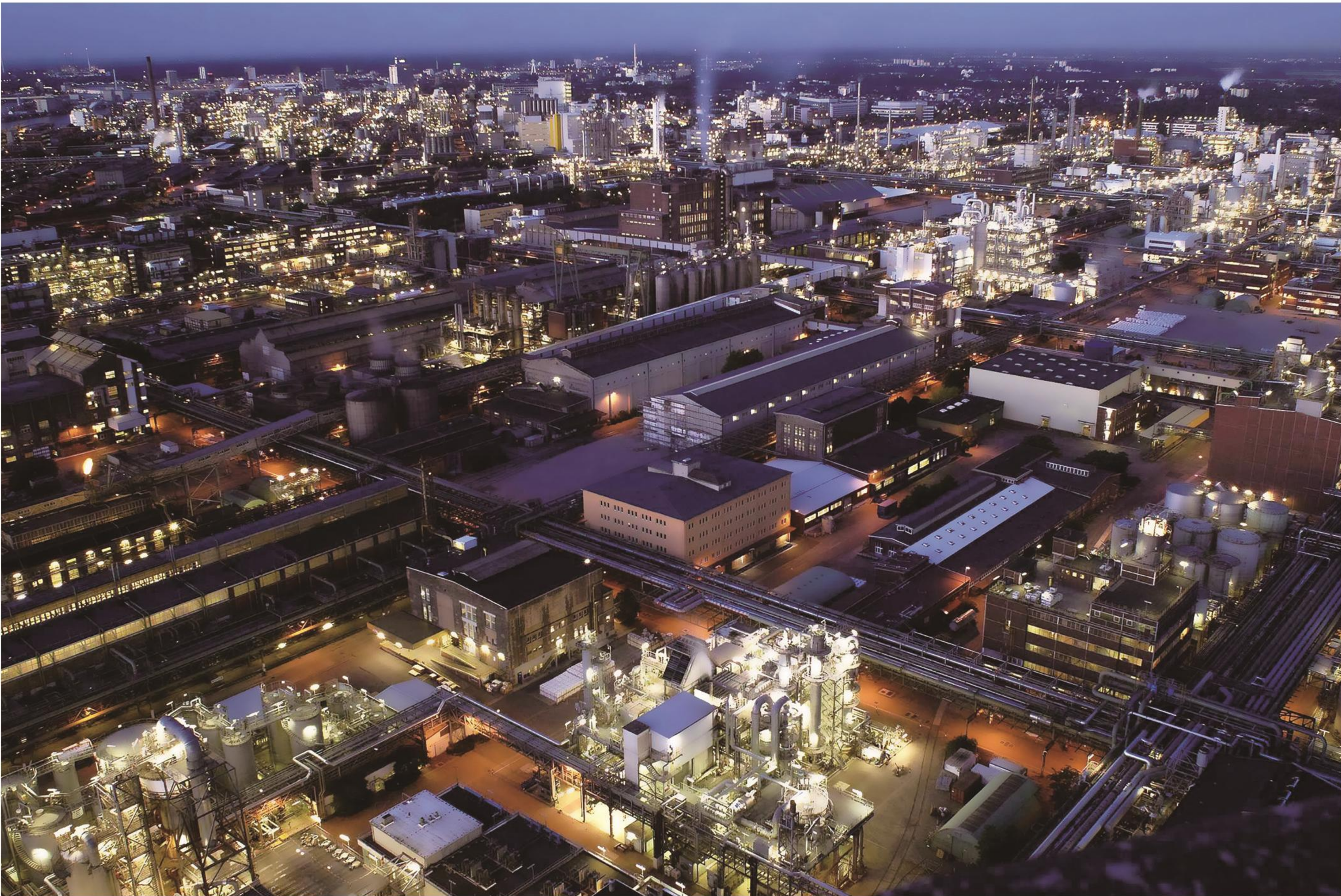
马来西亚PAPID项目 Malaysia PAPID Project
