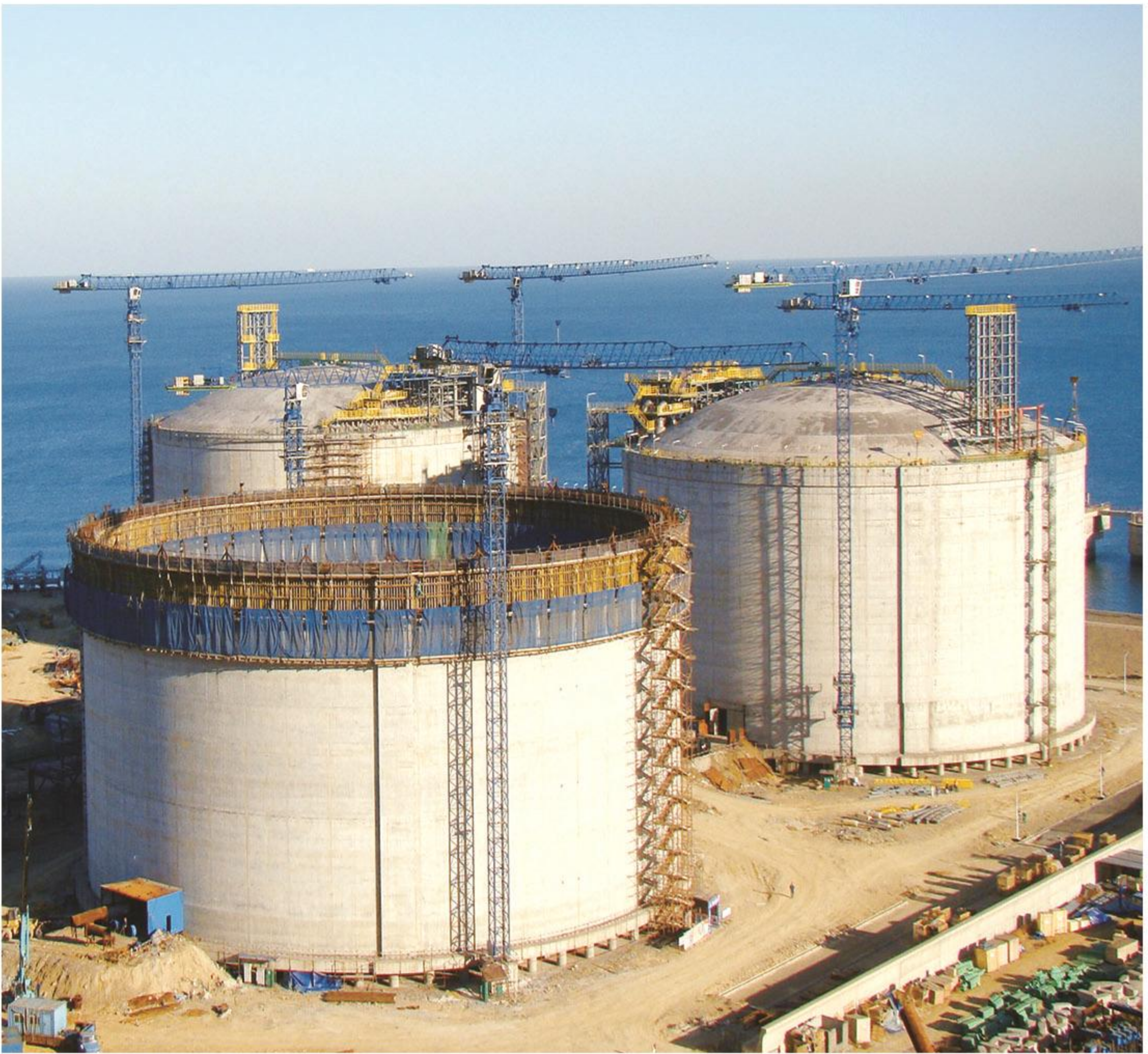
大型 LNG 储罐施工 Large LNG storage tank construction
